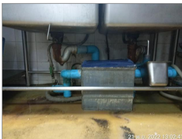
รูปที่ 2.2 ถังตัดไขมันใต้อ่างล้างจาน
