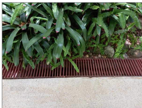
รูปที่ 2.5 ตะแกรงดักขยะ
