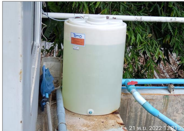
รูปที่ 2.3 ระบบคลอรีน
